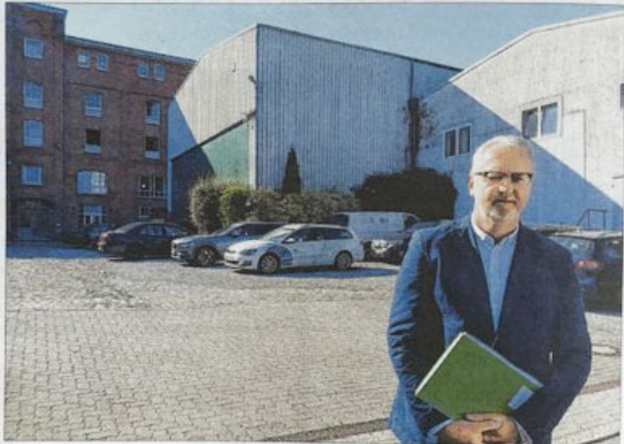
Hier sollte das ambulante Palliativzentrum entstehen. Travebogen-Geschäftsführer Thomas Schell vor dem Gelände in der Straße Am Spargelhof.
